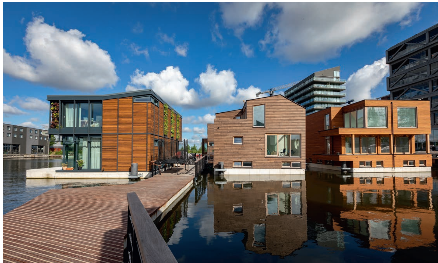
Die schwimmende Siedlung „Schoonschip“ besteht aus 30 Wassergrundstücken. Hier wird nicht nur sozial, sondern auch möglichst ökologisch neben- und miteinander gewohnt.
